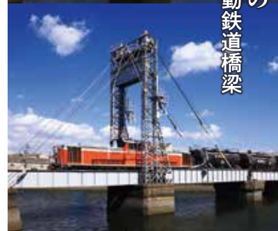
▲橋脚上に立つ高さ15.6mの鉄塔頂部からワイヤで巻き取り、桁を80度に跳ね上げる。国の重要文化財
